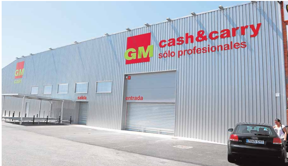
Nuevo Cash & Carry del Grupo Miquel instalado en Zamora
