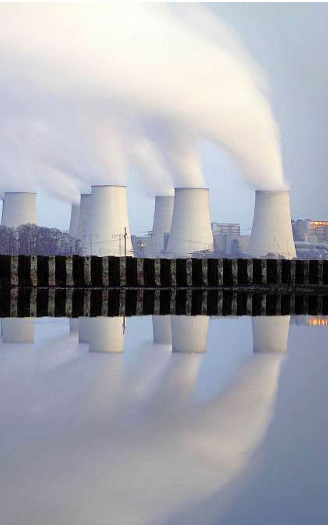
Torres de refrigeración de una central de carbón junto a un lago en Alemania
